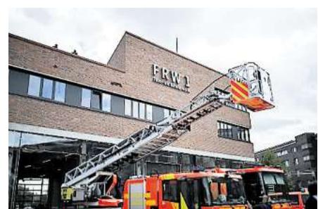
10 Millionen Euro hat der erste Teil der neuen Feuerwache gekostet. Foto: Treblin
